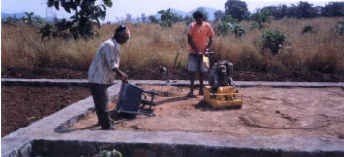
**Mit einer Rüttelplatte wird das Füllmaterial festgedrückt, danach leicht Sand aufgelegt und mit Ziegelsteinen belegt. Darüber kommt der Beton**
