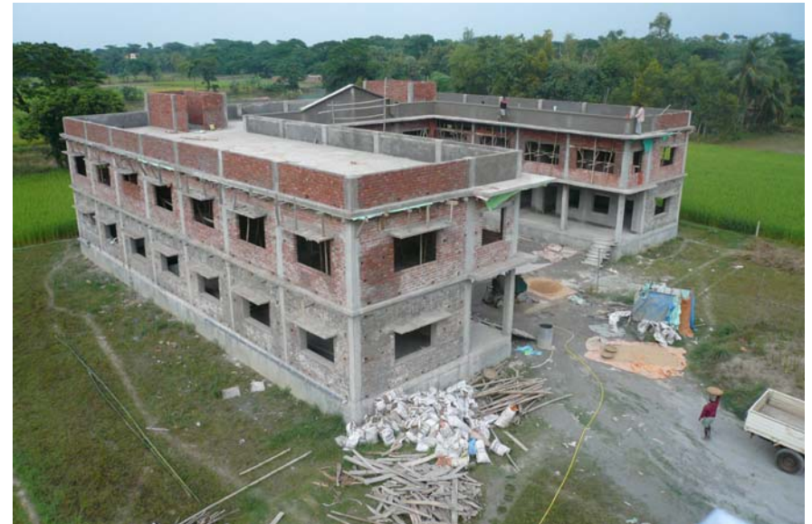
Im Sommer konnte das Obergeschoss der neuen Schule fertig gestellt werden
