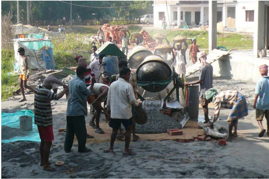
Zum Betonieren der Dachfläche liefen zwei Maschinen. Wir mussten ständig daneben stehen, damit stets das gleiche Beton-Mischverhältnis angesetzt und keine Zutat vergessen wurde.
