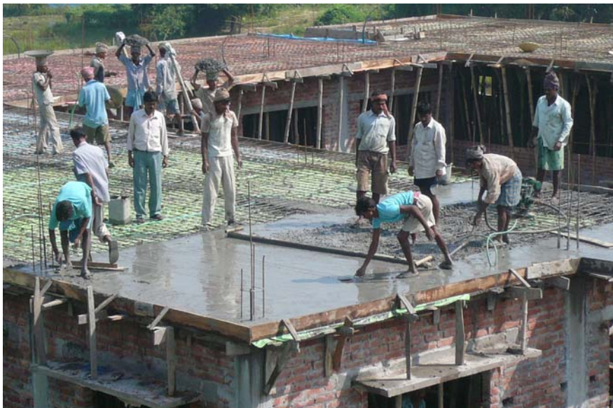
Zum Betonieren der Dachfläche liefen zwei Maschinen. Wir mussten ständig daneben stehen, damit stets das gleiche Beton-Mischverhältnis angesetzt und keine Zutat vergessen wurde.
