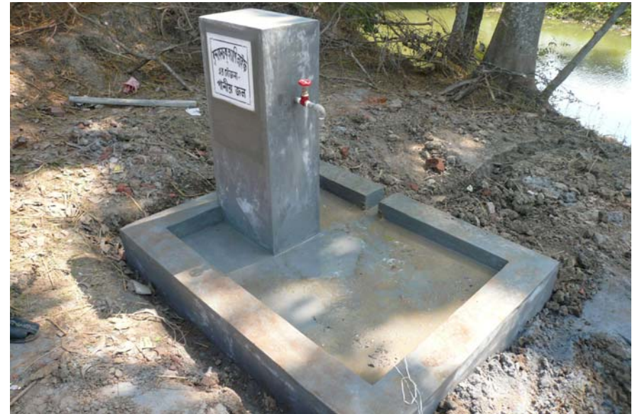
Für die Bevölkerung haben wir zwei Zapfstellen für Frischwasser gebaut
