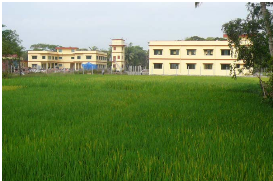
links das Ärztehaus, Mitte der Wasserturm, rechts das Schulhaus
